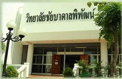
อาคารอำนวยการ
